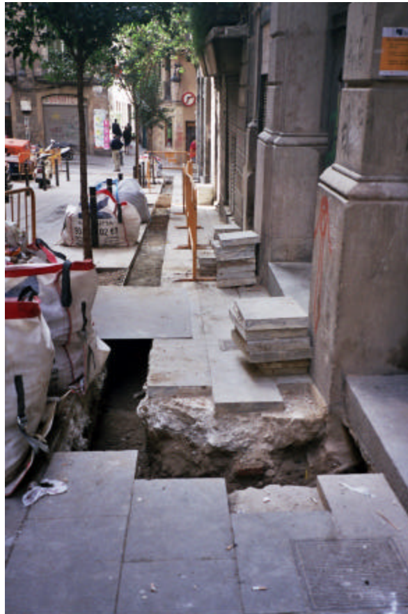
Foto 5. Vista general del traçat del primer tram de rasa.
