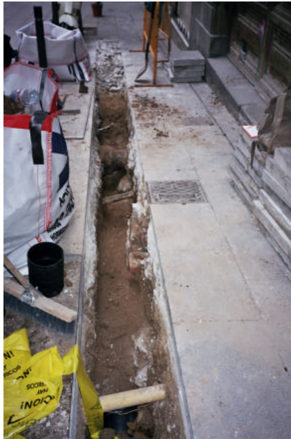
Foto 3. Detall del primer tram de rasa on es pot observar la gran quantitat de serveis soterrats.
