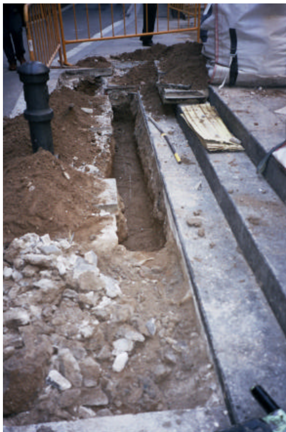
Foto 7. Detall del punt final de la rasa.
