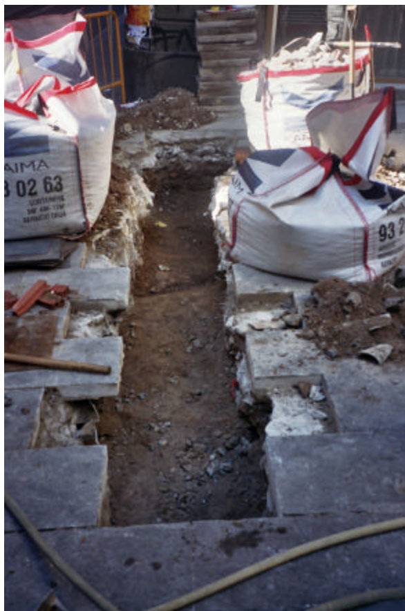
Foto 6. Detall del segon tram de rasa, travessat pel col·lector de la claveguera.
