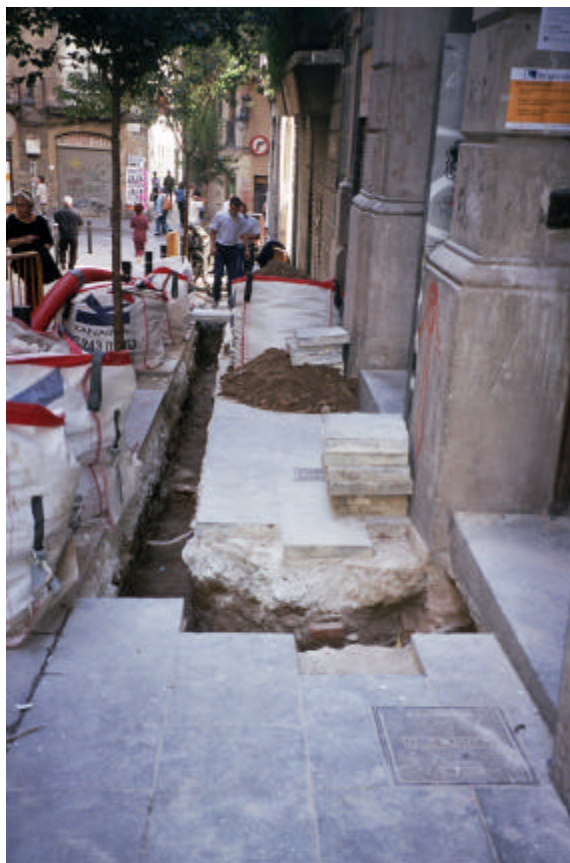
Foto 1. Vista de la cata oberta davant del número 3 del carrer Cervantes i de l'inici del primer tram de rasa, on es pot apreciar l'estructura U.E. 04.
