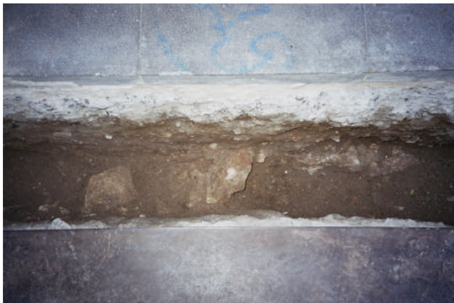
Foto 2. Detall de l'estructura U.E. 04
